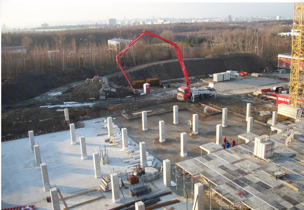
Montáž prefabrikovaných sloupů. Foto: Metrostav, a. s.
