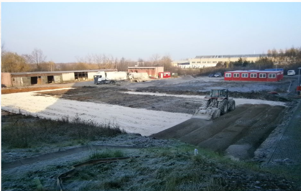
Zahájení stavebních prací. Foto: Metrostav, a. s.
