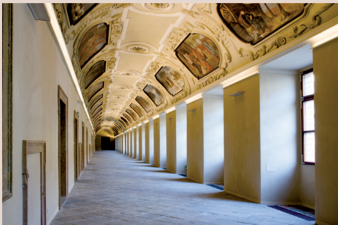
Chodba v 1. patře po rekonstrukci křídla do Křižovnické ulice. Foto: Eva Hodíková
