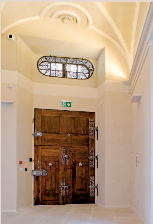
Masivní dřevěné dveře v přízemí revitalizovaného křídla do Křížovnické ulice. Foto: Eva Hodíková
